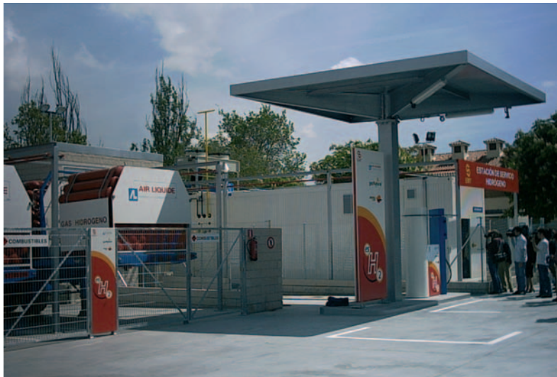
→ Estación de Servicio de Hidrógeno de Madrid. Fuente: Ariema.
