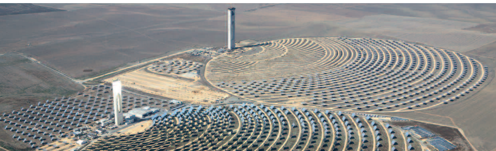
- Figura 2. Torre solar de San Lucar la Mayor, en Sevilla. En terrenos baldíos del vertido tóxico de Aznalcóllar la empresa de ingeniería Abengoa ha instalado una torre de concentración mediante espejos que vaporiza agua para mover una turbina en la torre.
