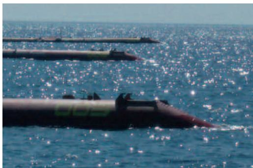
→ Vista del primer parque pre-comercial de energía de las olas. Portugal.
