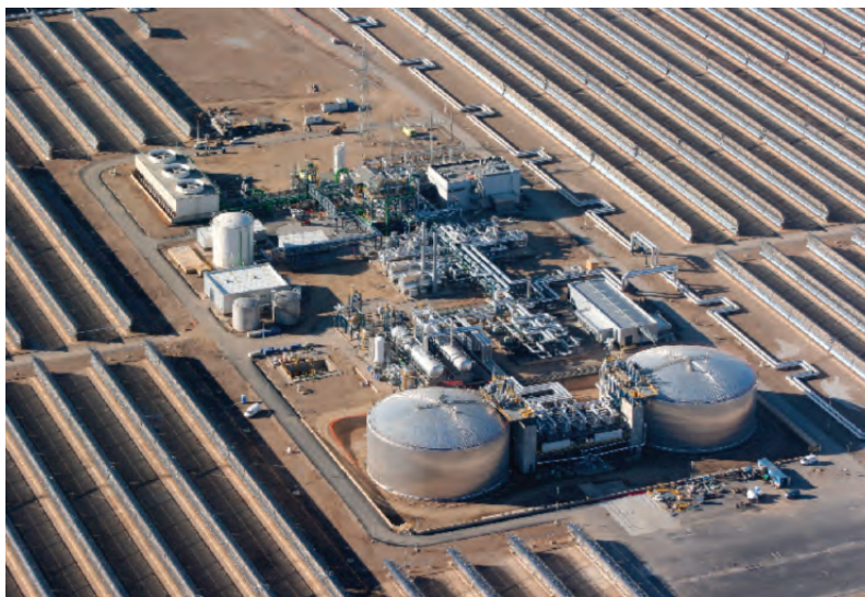
→ Figura 5. Bloque de potencia de Andasol I. 2 torres: \varnothing = 36 m; h = 14 m 28,500 tm de sales fundidas 7,5 h de almacenamiento a 50 MW
