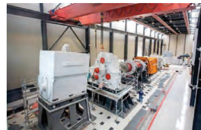
→ Infraestructuras de ensayos de tren de potencia de aerogeneradores en CENER
