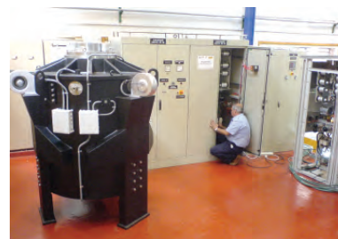
→ Instalación de almacenamiento cinético para el proyecto ACE 2
